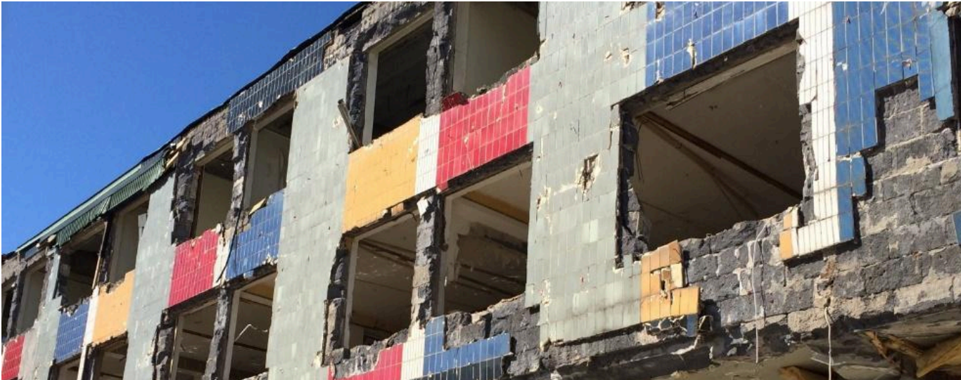
Figur 2. Rivning av ett flerfamiljshus.
